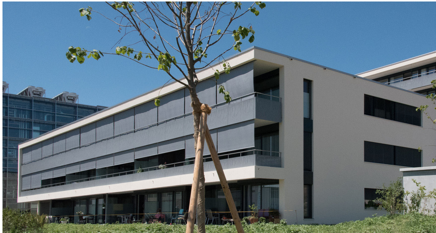
Abb. 1 Ansicht des Gebäudes Breitenfeldstrasse 4, Blick Richtung Westen (Quelle: www.medizentrum-taeuffelen.ch )
