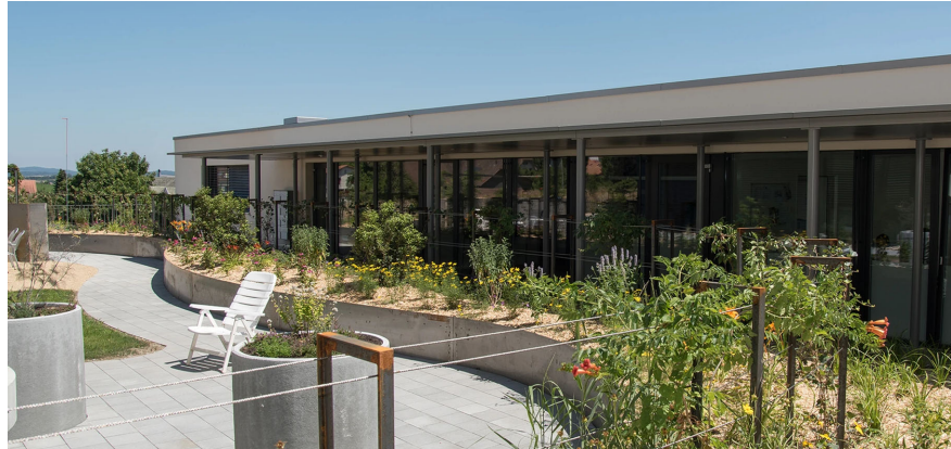
Abb. 6 Terrasse nördlich des Gebäudes Breitenfeldstrasse 4; die Aufstockung erfolgt oberhalb des im Bild sichtbaren Geschosses (Quelle: www.medizentrum-taeuffelen.ch ).
