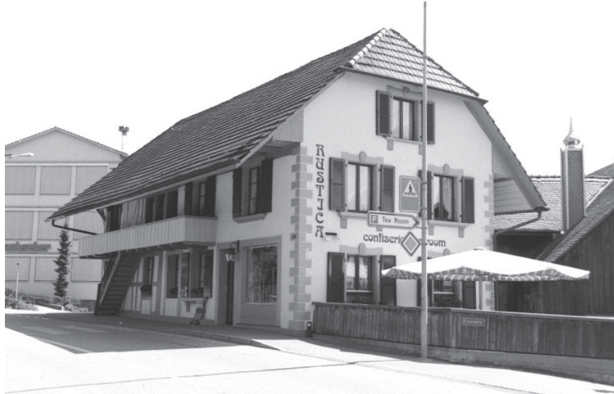
Abb. 10 Erhaltenswertes ehem. Stöckli, Hauptstrasse Nr. 103 (Quelle: Geoportal des Kantons)
